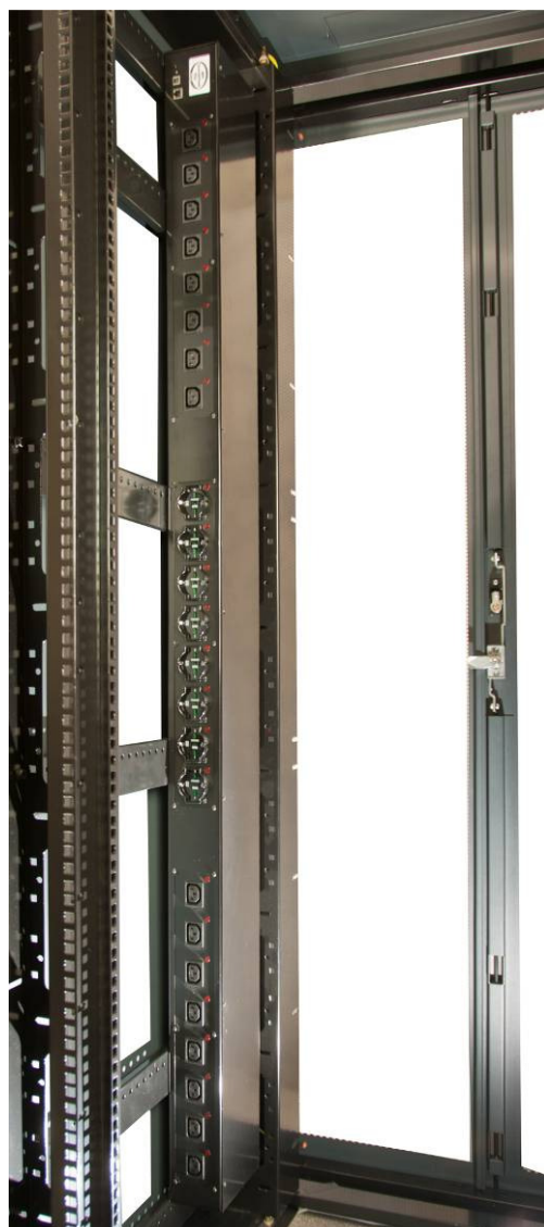
Multipresa verticale a 24 prese : 16 IEC C13 e 8 prese UNEL universali. La disposizione delle prese viene effettuata su richiesta specifica.
